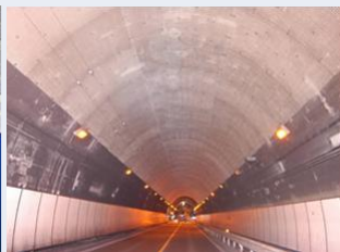
写真-2 トンネル覆工 全面取付例
