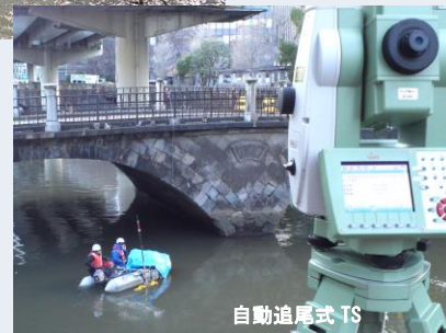
橋梁下部での C3D計測・調査
