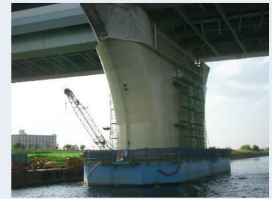
鋼製締切函体設置状況
