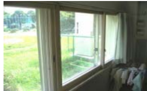
防音サッシ設置
