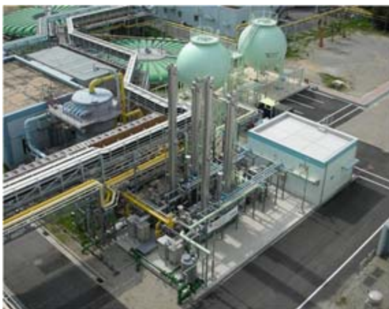
図 4.219 バイオ天然ガス化装置（神戸市東灘処理場）
