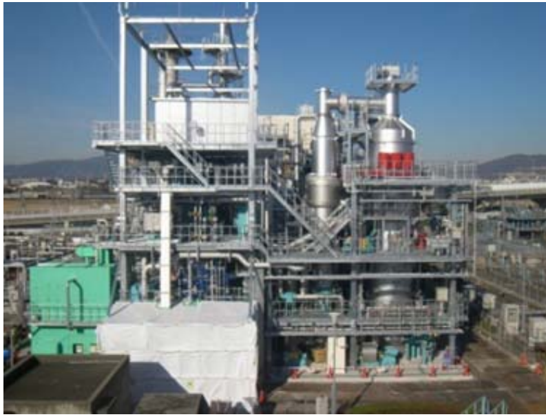
図 4.225 低含水率脱水による焼却炉の自燃化（B-DASH、池田市下水処理場）
