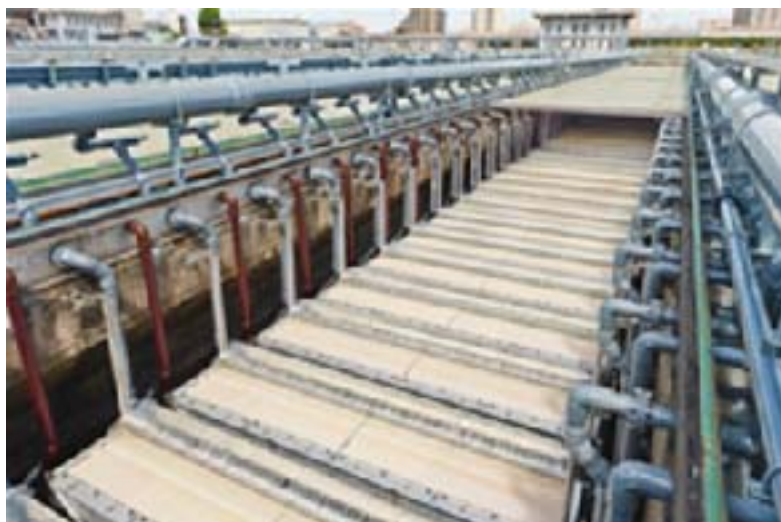
図 4.222 MBR 施設（堺市 三宝下水処理場）
