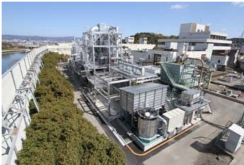
図 4.224 低含水率脱水による焼却炉の自燃化 (B-DASH、和歌山市中央終末処理場)
