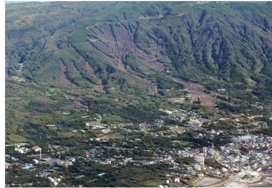
図-2.4 台風26号豪雨による伊豆大島の表層崩壊(関東地方整備局提供)
