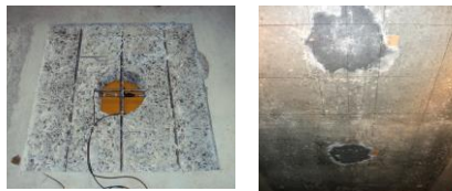
補修前上面 補修後下面 模擬損傷試験体
