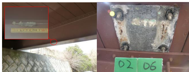
写真-1 橋梁の実態調査（左：外的要因による損傷、右：高欄取付部下面のベースプレートの腐食）
