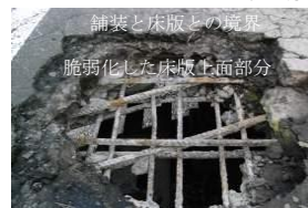
RC 床版の上面脆弱化後の陥没例
