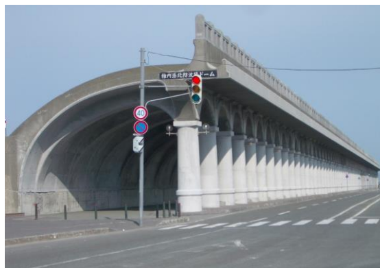
写真-1 稚内港北防波堤ドーム
