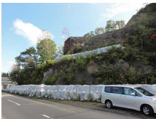
写真-3 恵庭市の道路斜面応急対策
