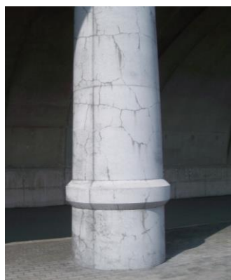
写真-3 支柱部の劣化
