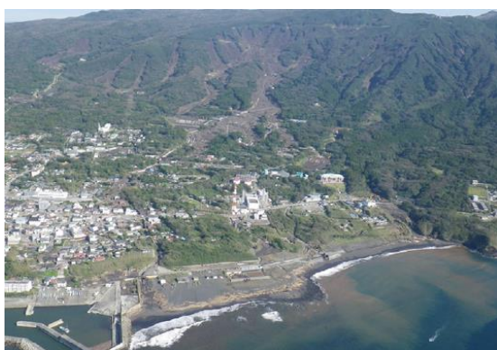
写真-1 東京都大島町の土砂災害
