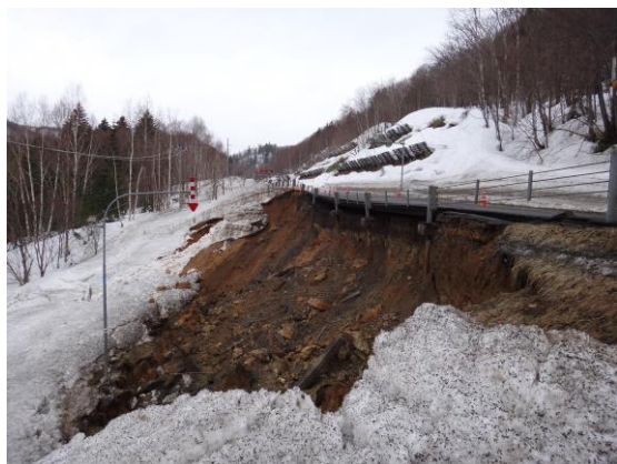
写真-1 国道 230 号の盛土法面の崩壊
