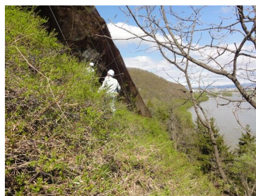
写真-4 旭川市の自転車道斜面の調査
