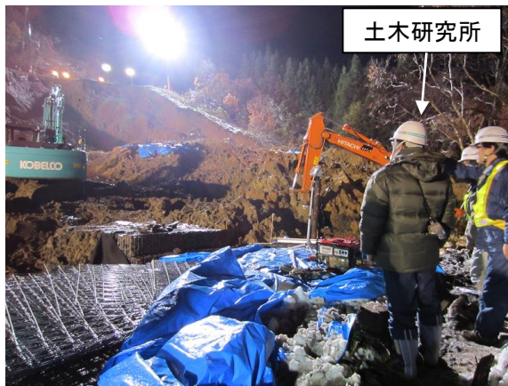
写真-2 不安定土砂の掘削方法の指導
