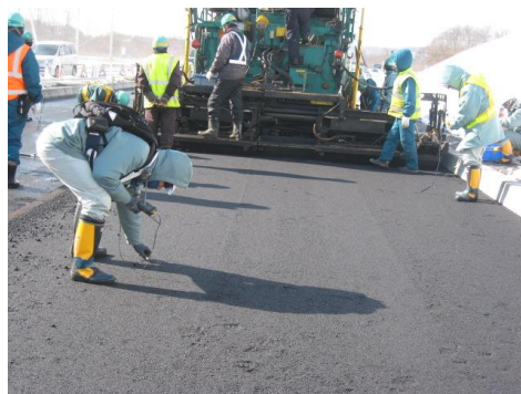
写真-2 中温化混合物の温度測定状況
