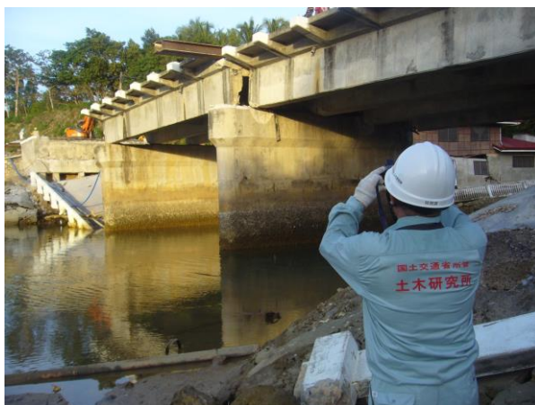
写真-1 落橋した橋の調査
