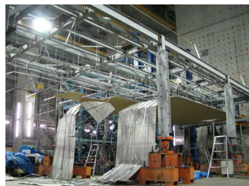
写真 5 クリップの外れによる天井面の落下
