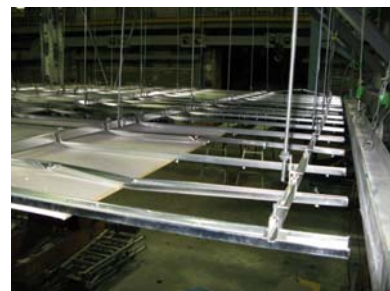
写真 6 耐風圧クリップ使用でのボード落下
