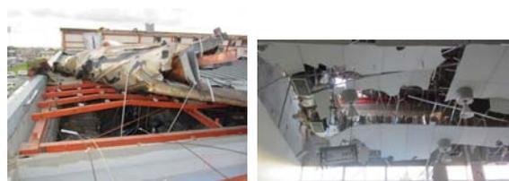
図3 鉄骨造の文教関連施設の屋根ふき材と天井材の被害
