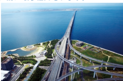
空港と道路をむすぶ『アクセス道路』
