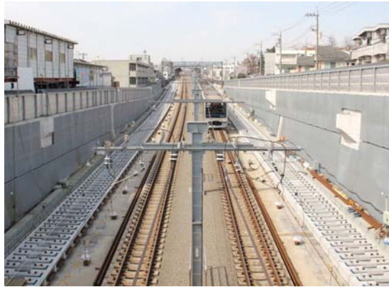
写真 1.1.2-6 世田谷代田～梅ヶ丘間軌道 工事状況
