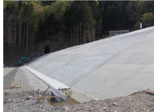
写真 1.1.3-10 盛土構造復旧工事の状況
