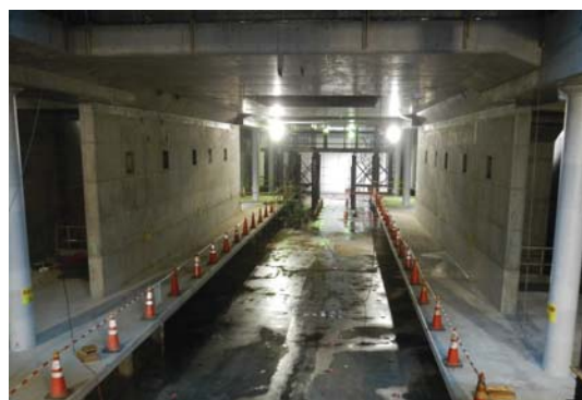
写真 1.1.2-2 相鉄・JR直通線 羽沢駅(仮称)の施工状況
