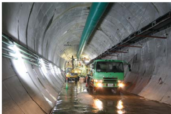
写真 1.1.2-1 相鉄・JR直通線 西谷トンネルの施工状況
