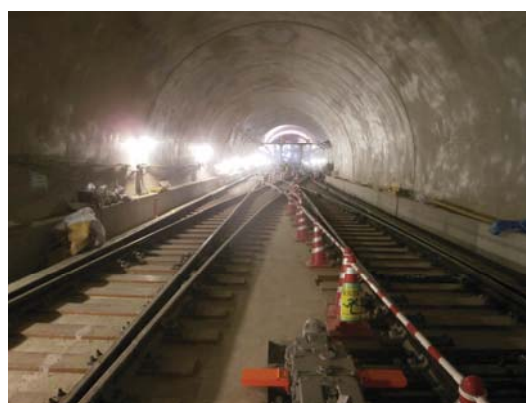
写真 1.1.3-4 仙台市高速鉄道東西線 八木山トンネル軌道工事状況
