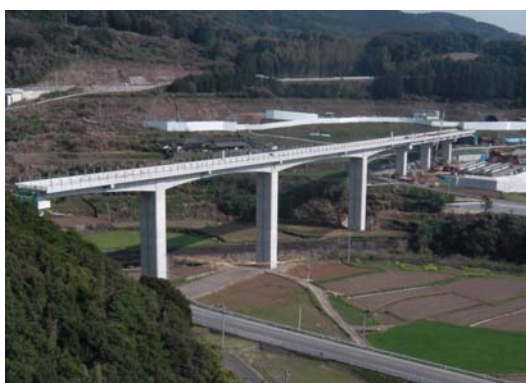
写真 1.1.1-6 千綿川橋りょうの施工状況
