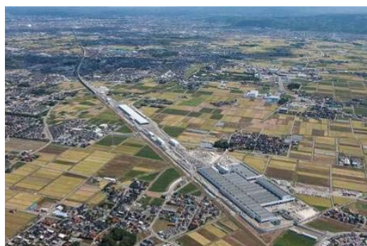
写真 1.1.1-3 白山総合車両所
