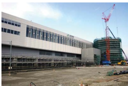
写真 1.1.1-1 上越妙高駅の施工状況
