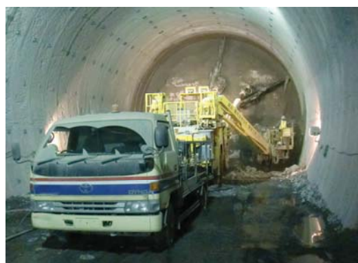
写真 1.1.1-7 三坂トンネルの施工状況
