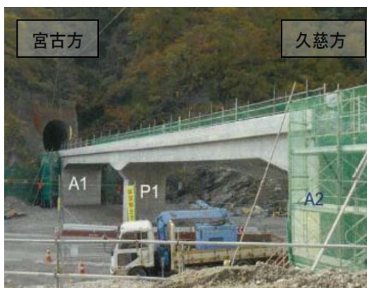
写真 1.1.3-8 GRS 一体橋梁施工状況
