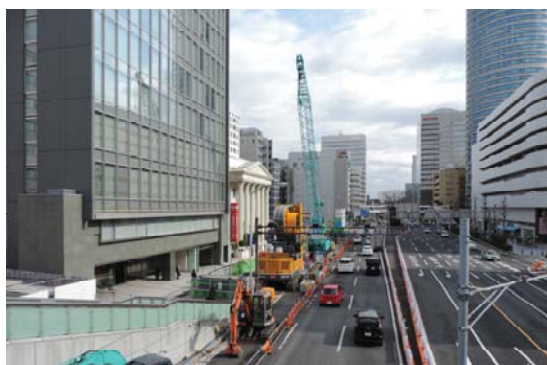
写真 1.1.2-3 相鉄・東急直通線 新横浜駅(仮称)の施工状況
