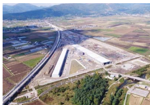
写真 1.1.1-5 函館総合車両基地の施工状況
