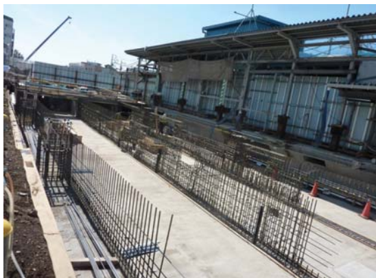
写真 1.1.2-4 東北沢駅付近躯体構築及び旧駅舎撤去状況
