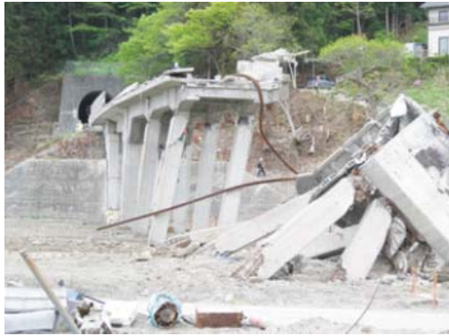
写真 1.1.3-9 高架橋被災状況
