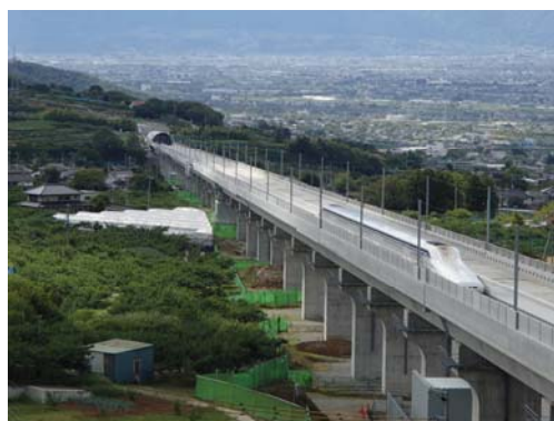
写真 1.1.3-5 山梨リニア実験線 走行試験実施状況
