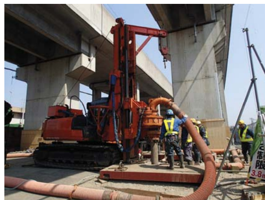
写真 1.1.3-6 場所打杭施工状況
