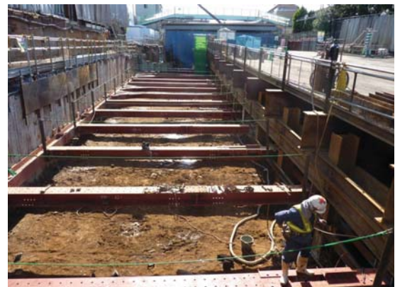
写真 1.1.2-5 下北沢～世田谷代田間緩行線部掘削状況
