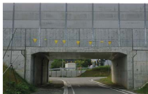
写真 1.1.4-1 現在の中学校線架道橋の様子
