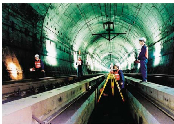
写真 1.1.4-2 覆工コンクリート内空変位量計測状況
