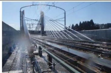
散水消雪 冬季試運転の例 東北新幹線（八戸・新青森間）
