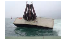
緊急確保航路における啓開作業
