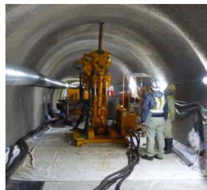
集水ボーリング工
