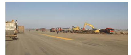
滑走路に堆積した土砂の処理作業 (東日本大震災における仙台空港)
