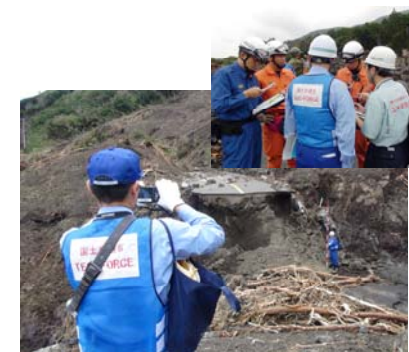
自衛隊や消防と連携し、被害状況調査を実施 (H25年、伊豆大島)
