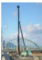
揖斐川施工状況
