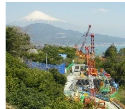
深礎杭工の施工遠景
