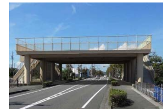
道路上の津波避難タワー (静岡県吉田町/H25年度完成)
