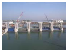
日光川水閘門 施工状況 [水管理・国土保全局、港湾局]
