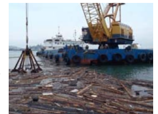
航路啓開作業に従事するグラブ船 (東日本大震災)
