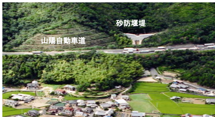
砂防堰堤の整備により山陽自動車道を保全 (広島県三槍谷砂防堰堤)
