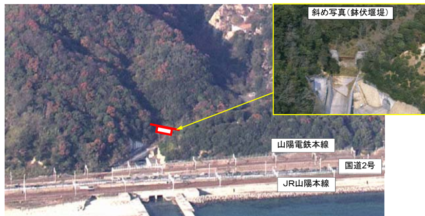
砂防堰堤の整備によりJR山陽本線、国道2号等を保全 (兵庫県鉢伏砂防堰堤)
