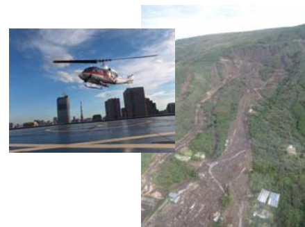
発災後、迅速にヘリコプターを発信 上空より被害状況を調査 (H25年、伊豆大島)
