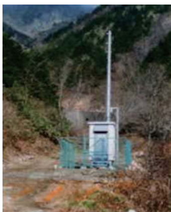
写真-1 雨量観測設備
