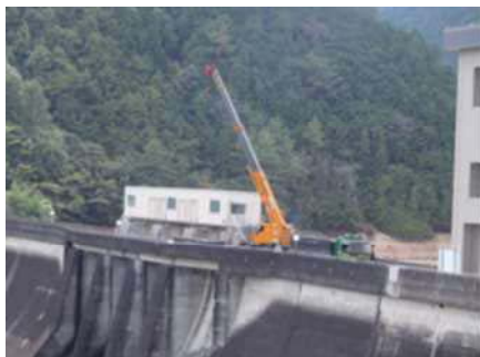
写真-3 資材搬入状況
