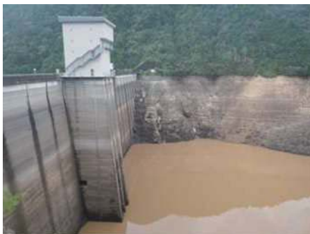
写真-1 宇連ダム貯水状況 (貯水率0.8%：平成25年9月3日)
