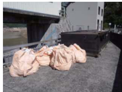
写真-4 台船、土のう等準備状況
