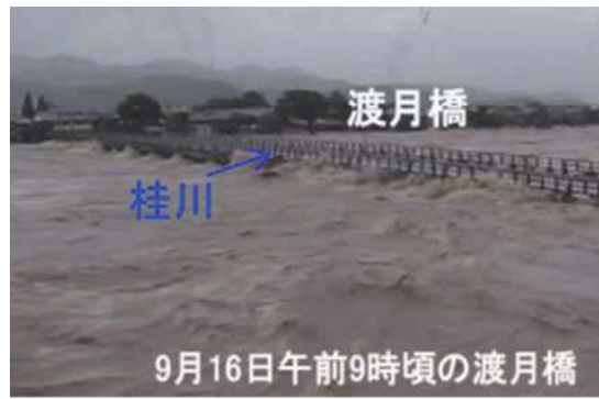
写真-4 渡月橋の状況写真
