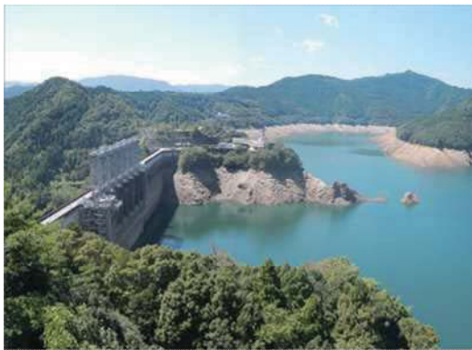
写真－6 早明浦ダム貯水状況(貯水率 25.9%) 平成25年8月27日
