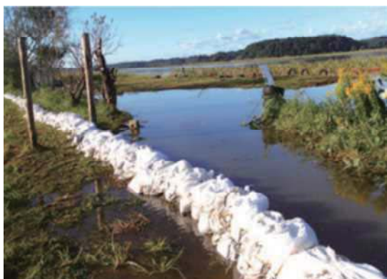
写真-6 土のう積み応急対応状況
