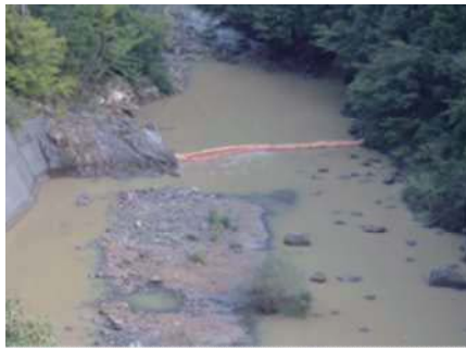
写真-5 濁水防止フェンス設置状況
