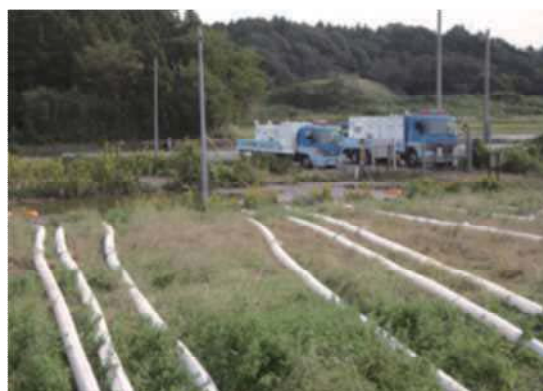
写真-7 ポンプ車排水状況
