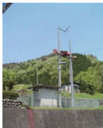
写真-2 警報設備
