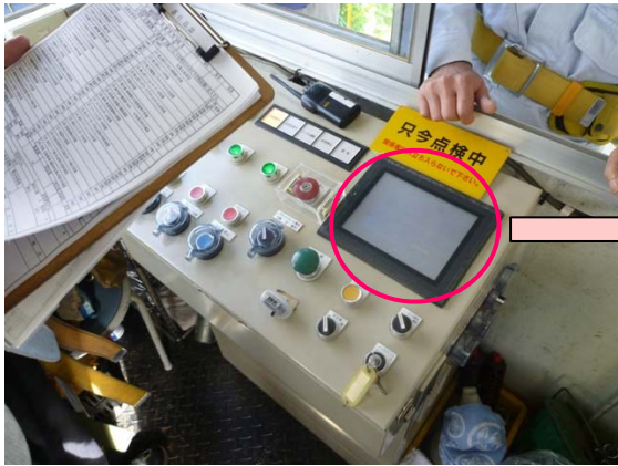
写真7 運転操作盤全体
