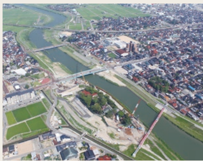
分水路改修事業
