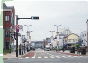
③れんが花道通り…「都市計画 道路小松駅前線」道路拡幅、電柱 地中化、歩道新設、イベント広場を 整備
