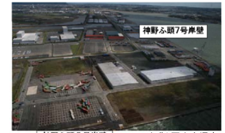
【被災状況写真】
