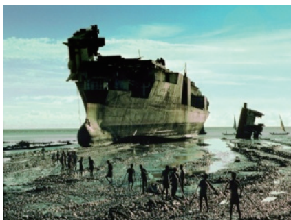
発展途上国における船舶解体の様子
