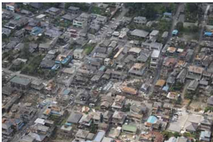
竜巻による被害状況（茨城県つくば市）
