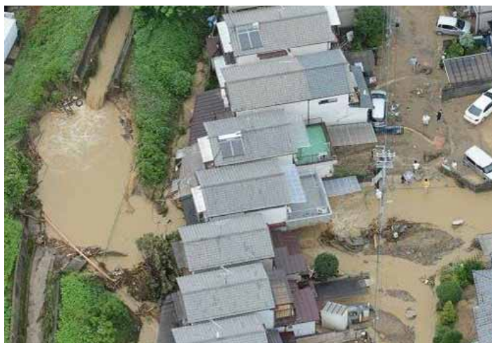
京都府宇治市 弥陀次郎川決壊状況 【写真提供 / 近畿地方整備局】
