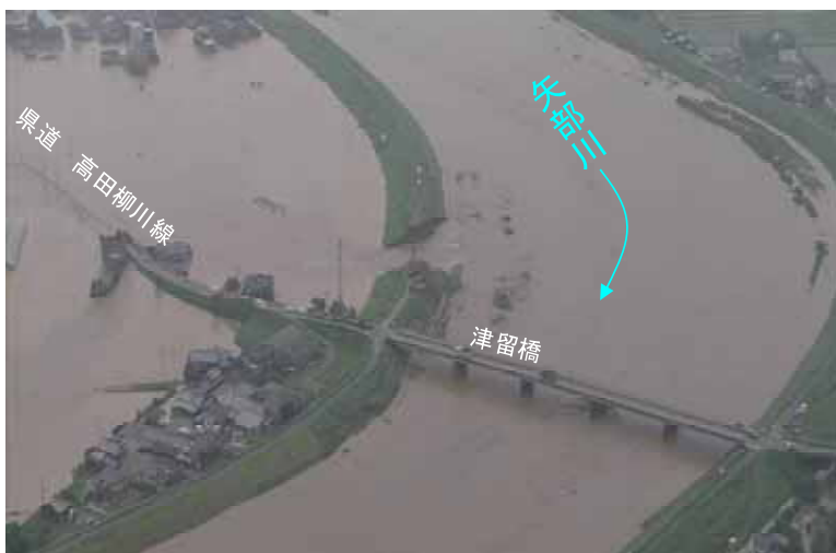
柳川市大和町 堤防決壊状況 【写真提供 / 九州地方整備局】
