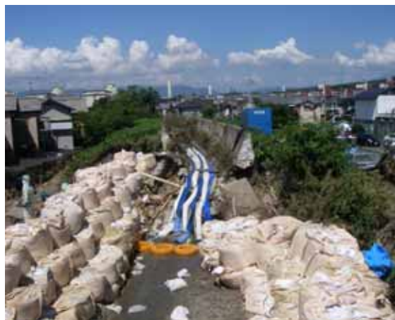
京都府宇治市 弥陀次郎川応急復旧状況 【写真提供 / 近畿地方整備局】
