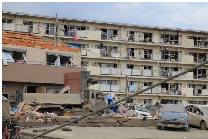
竜巻による被害状況
