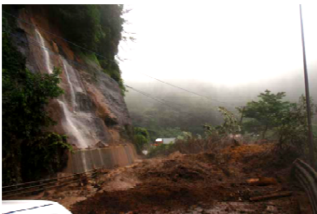
熊本県阿蘇市滝室坂 国道57号法面崩落状況 【写真提供 / 九州地方整備局】
