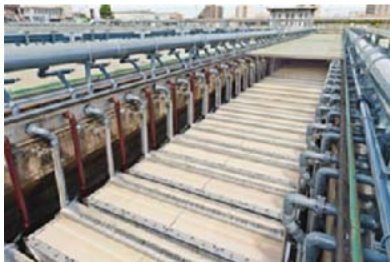
図 4.221 MBR 施設（堺市 三宝下水処理場）
