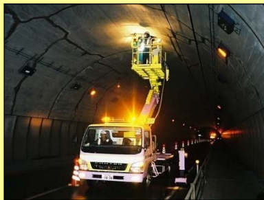
【近接目視によるひび割れ探査②】
