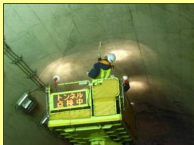
【近接目視によるひび割れ探査②】
