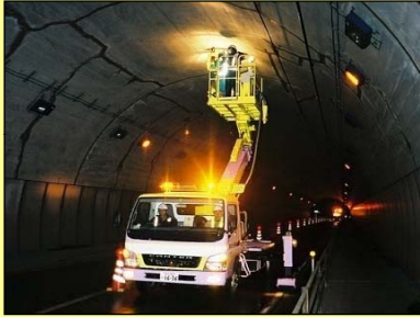
【近接目視によるひび割れ探査①】
