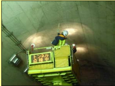
【近接目視によるひび割れ探査②】
