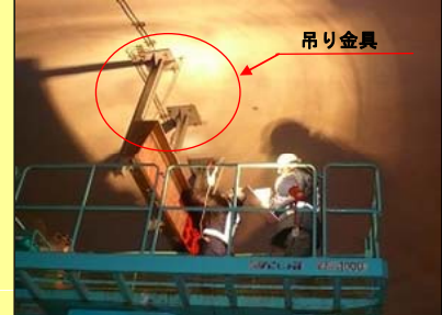
【トンネル内附属物(照明等)の点検②】
