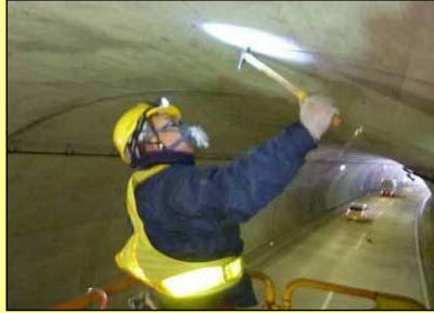
【ハンマーによる打音検査①】
