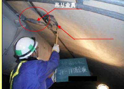
【ハンマーによる打音検査②】
