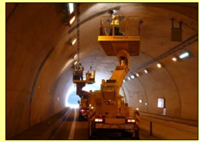
【トンネル内附属物(照明等)の点検①】
