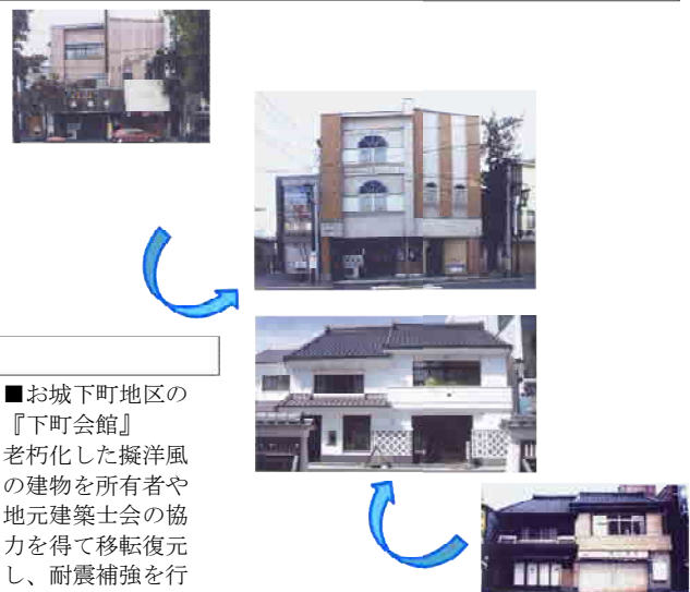
ファサード改修事例
