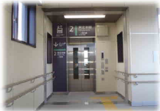
エレベーター設置
