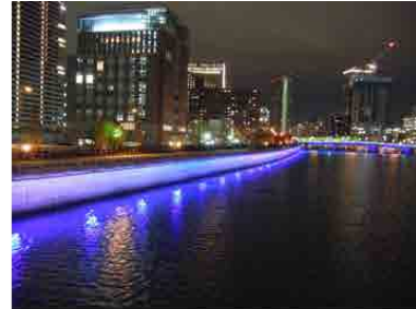
【ライトアップ照明施設整備(大阪府)】
