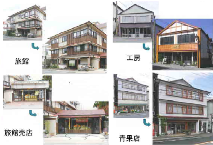
ファサード改修事例
