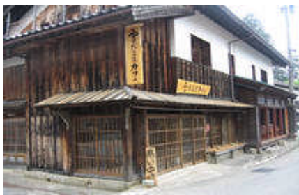
(古民家の再生・活用)
