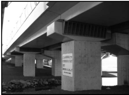
<橋梁の耐震補強>
