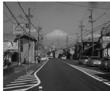
<美観を損ねる電柱・電線>
