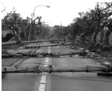
<電柱の倒壊による道路閉塞>
