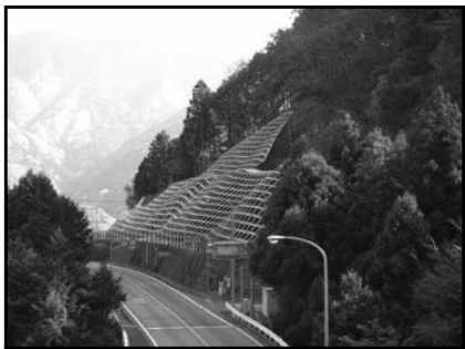
<斜面崩落防止対策>
