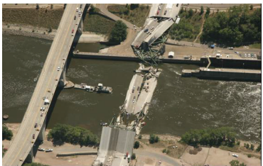
ミシシッピ川に架かる高速道路橋の落橋事故(2007年米ミネソタ州)(出典:MN/DOT)
