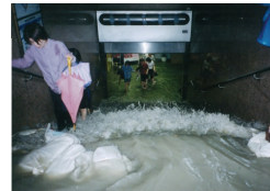
地下鉄駅への雨水の流入
