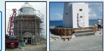
【耐震補強】 【耐波浪補強】
