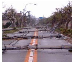
<電柱の倒壊による道路閉塞>
