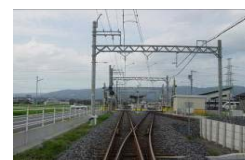
行き違い設備
