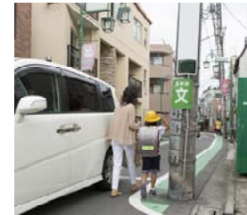
<歩行の支障となる電柱>
