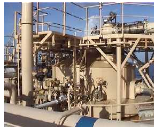
配管継手部等の漏洩対策
