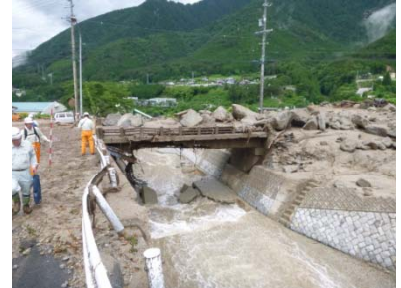
⑥県道橋被災状況
