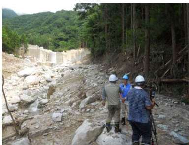
⑦砂防堰堤下流状況
