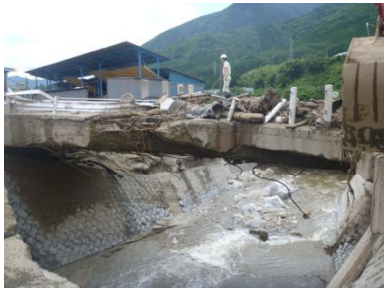
④町道橋被災状況1
