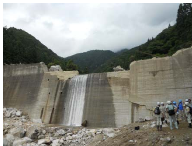
⑧砂防堰堤被災状況
