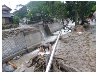
⑤町道橋被災状況2
