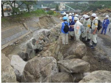
①護岸決壊状況
