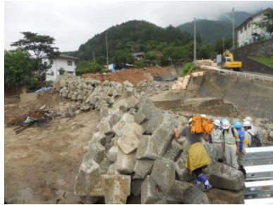
②応急工事状況
