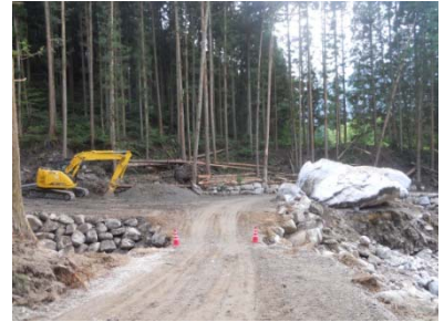
③仮道の状況
