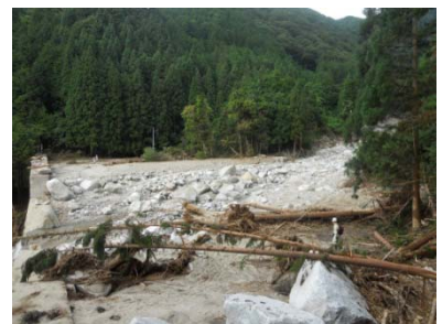
⑨砂防堰堤土砂埋そく状況
