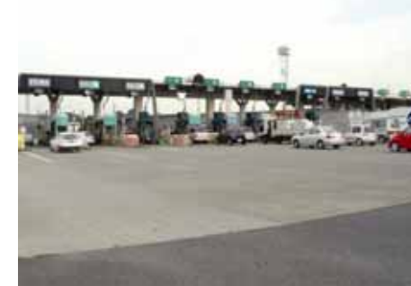
新座本線料金所(関越自動車道)
