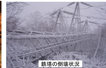
鉄塔の倒壊状況
