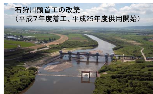
石狩川頭首工の改築(平成7年度着工、平成25年度供用開始) ・頭首工等の整備により営農に必要な用水を確保し、農業経営の安定化を図り、良食味米の安定生産が可能に
