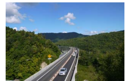
道東自動車道(夕張IC～占冠IC)供用(H23)
