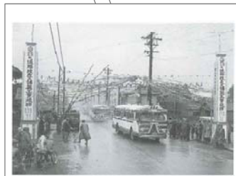
昭和28年 札幌～千歳間(国道36号) 舗装完成
