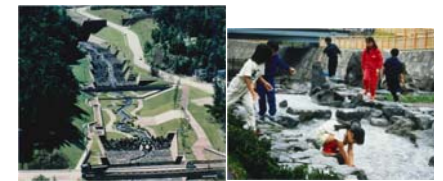
十勝岳流路工 国立公園の良好な景観に配慮した整備を全国に先駆けて実施
