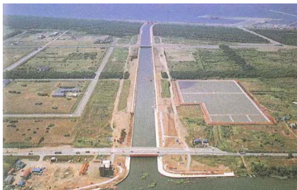
石狩放水路完成(S57)
