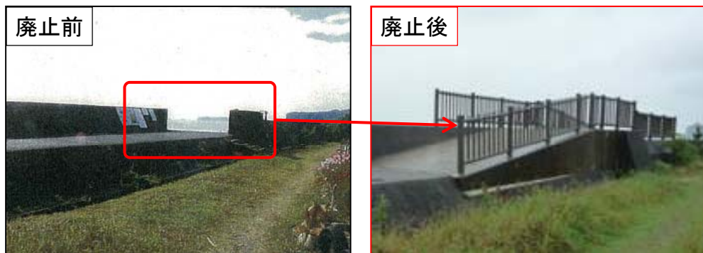
スロープを設置し陸閘を廃止
