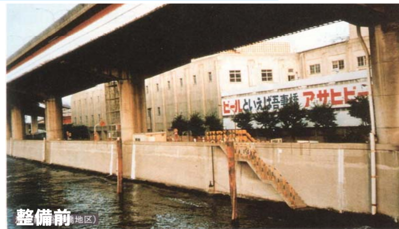
隅田川 吾妻橋地区の例（東京都）
