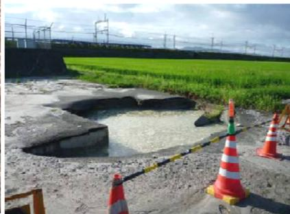
漏水による排泥工周辺陥没状況
