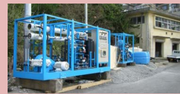
海水淡水化装置設置状況
