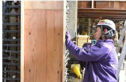
専用のハンマーを使ってコンパネと呼ばれるコンクリートパネルの位置を調整する眞砂さん。
