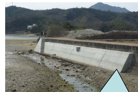
既設護岸のひび割れ等の補強としての、腹付コンクリートによる補修
