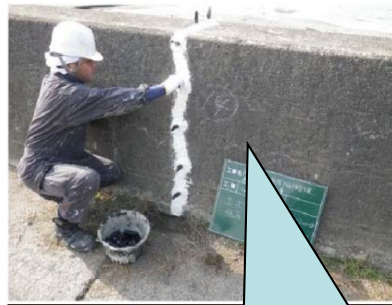
クラックにシーリング材を注入
