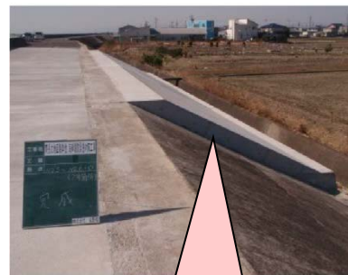
張りコンクリートによる増厚
