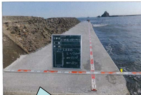
経年劣化したコンクリートの表面の修繕
