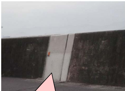
ひび割れの拡大した変状箇所を取り壊し、欠損部を補修
