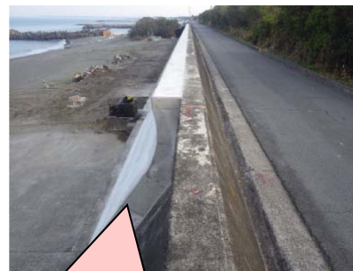
既設護岸を活用した、波返工と一体的な腹付コンクリートによる改良
