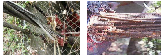
ケーブルの破断状況
