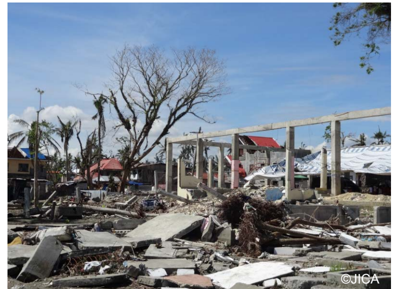
サンアントニオ周辺の被災状況
