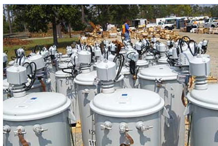
修理のために国中から集められた変圧器 (FEMAのHPより)
