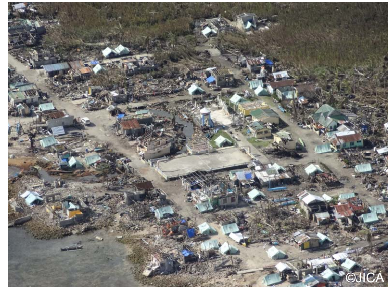
ギゴソ周辺の被害状況
