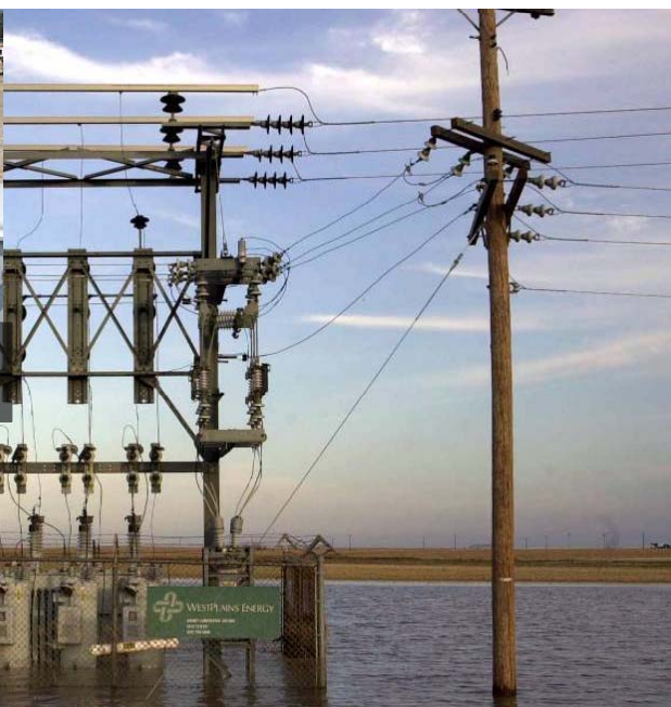
浸水による電力施設の損傷 (FEMAのHPより)
