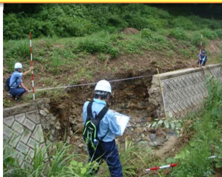
被災状況の把握 (H25. 8山口島根豪雨 島根県江津市)
