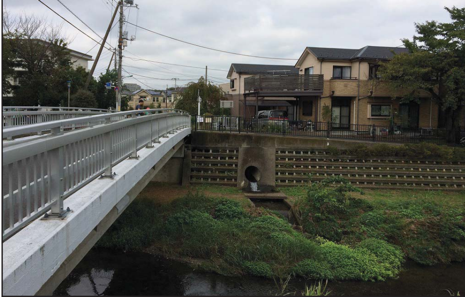
②野川 細田橋 (水路の排水口)
