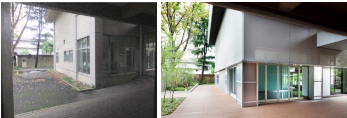
ポーチ（改修前・改修後）
