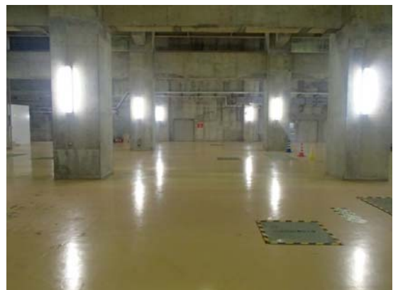
<汚泥処理棟 1 階>
