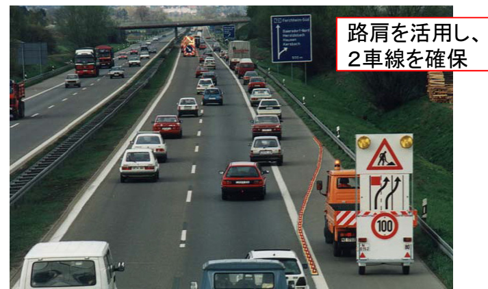
車線拡幅(アウトバーン8号線)
