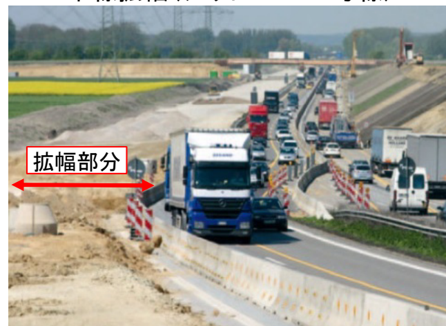
車線拡幅(アウトバーン8号線)
