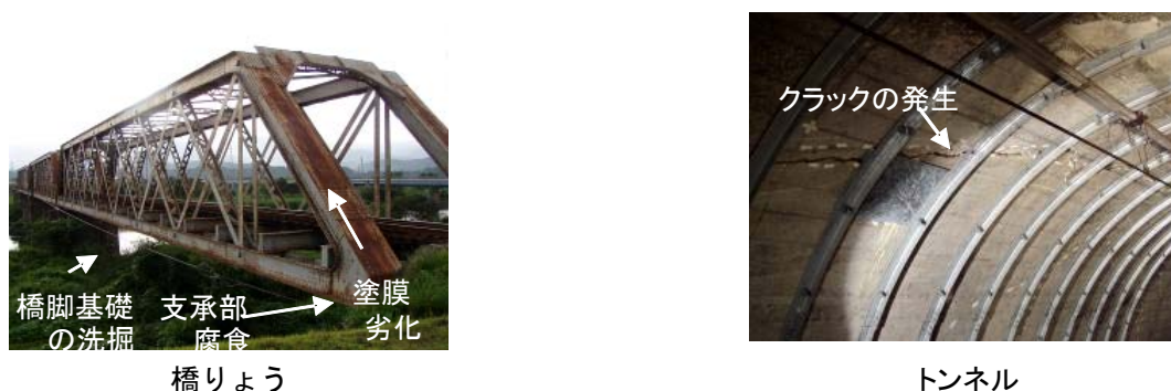
図4：老朽化が進んでいる施設の例
