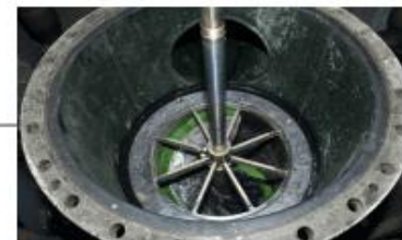
■ オートストレーナ内部 (上部より)
