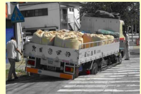
下水管きよに起因した道路陥没
