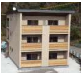
CLTにより整備された 社員寮 (高知県長岡郡大豊町)
