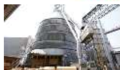
木質バイオマスによる発電施設
