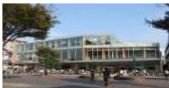
耐火集成材を使った 商業施設 (神奈川県横浜市)
