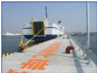
函館港の耐震強化岸壁の整備
