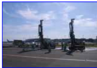
新千歳空港の液状化対策 施工状況
