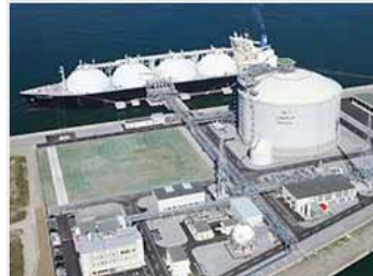
石狩LNG基地写真
