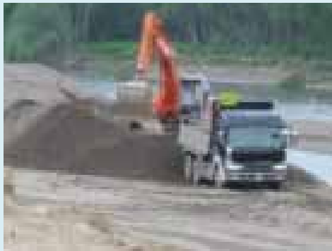
十勝川河道掘削
