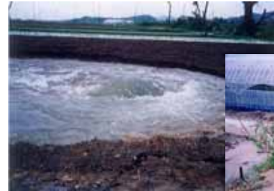
伊良湖サイホン漏水状況
