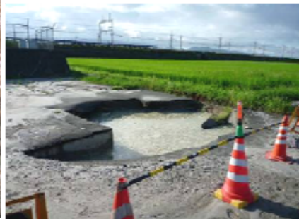
漏水による排泥工周辺陥没状況
